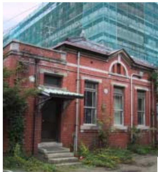
写真1 旧地殻変動研究室(本部構内) 後ろは建設中の事務棟
