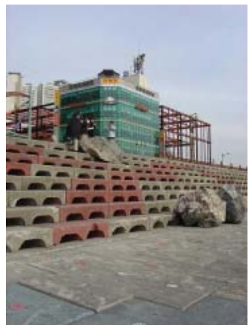
写真6 打ち上げられた巨大な石
