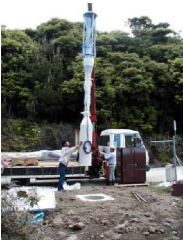
写真 3. クレーン車による建柱
