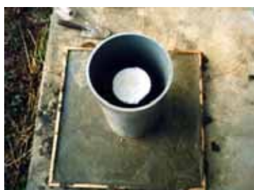
写真8 ベースと柱部分
