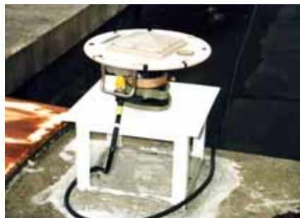
写真 11 アンテナ取り付け状況
