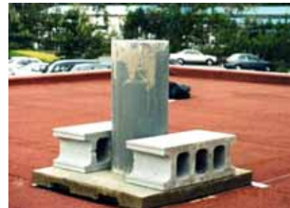
写真 27 大原アンテナ架台
