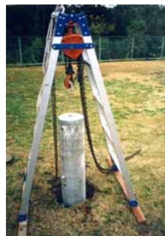
写真 22 建柱作業
