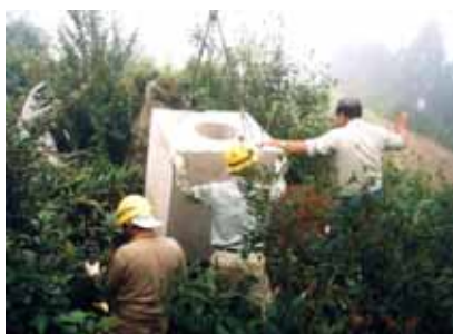
写真 14 コンクリート枡
