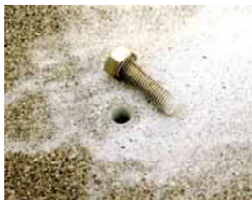
写真5 埋め込み穴とボルト
