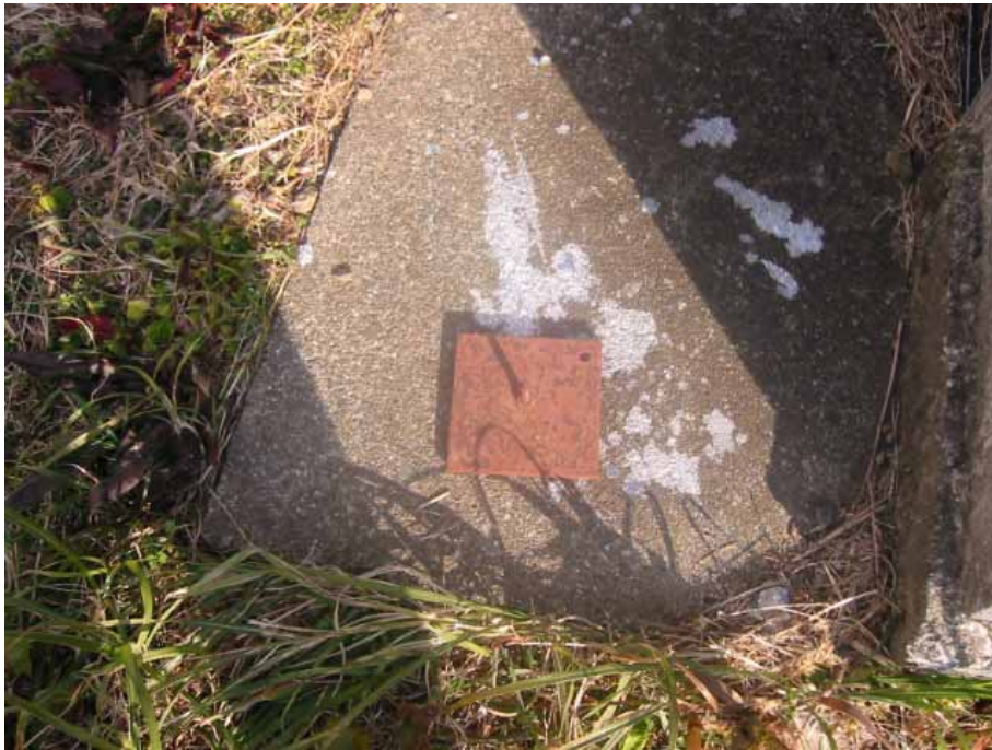
写真 15 鉄塔ずれ止板
