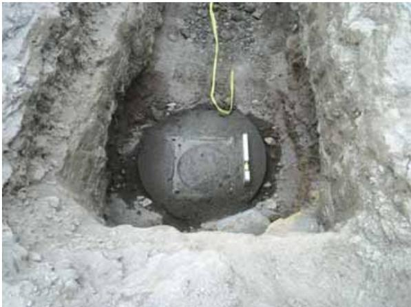
写真3 水管傾斜計センサ部の台
