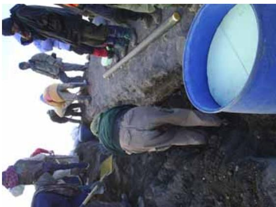
写真11 水管傾斜計の埋設
