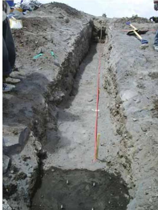
写真4 水管傾斜計設置用の穴
