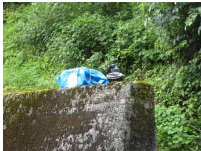
写真 2 地震計設置状況 2 路肩の崩落防止コンクリート壁上
