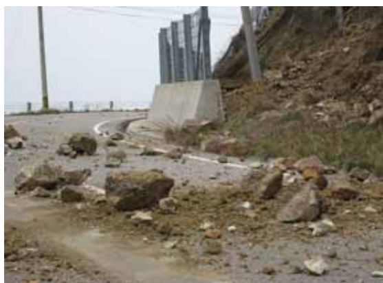
写真1 落石により通行止めとなっている。
