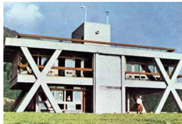
写真 2 ハルタ山観測所
