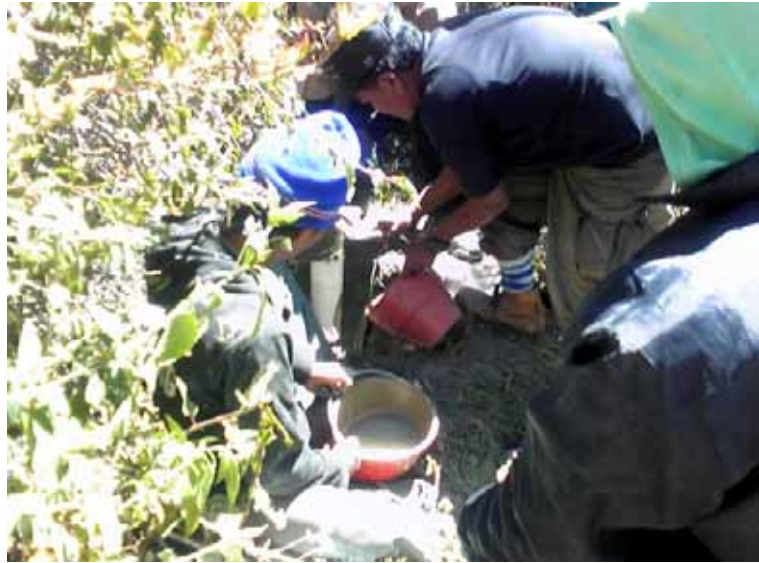
写真 4 ポアホール養生
