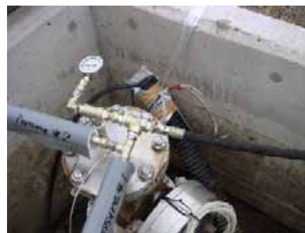
写真 14 観測小屋とボアホール
