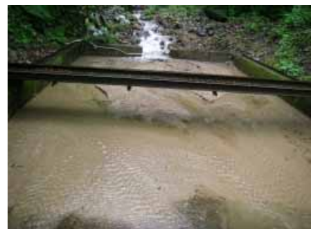
写真 2 試験堰堤土砂出し前
