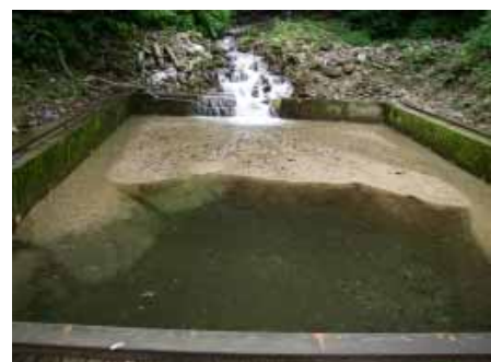
写真 3 土砂出し約 1 ヶ月後
