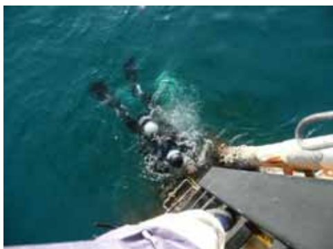
写真3 観測塔へのケーブル固定作業
