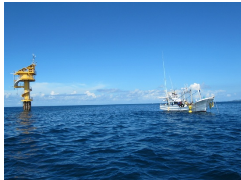
写真 5 : 観測塔と作業船
