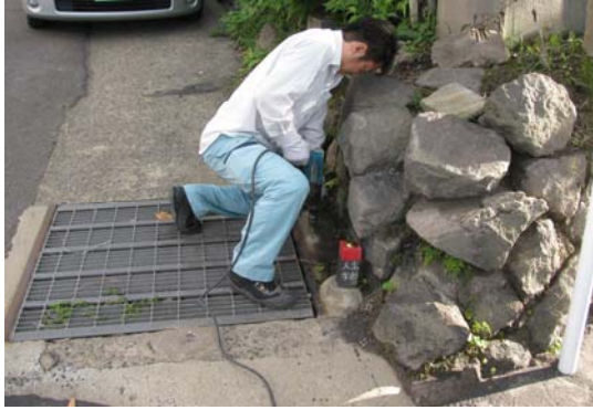
写真3 水準点設置作業
