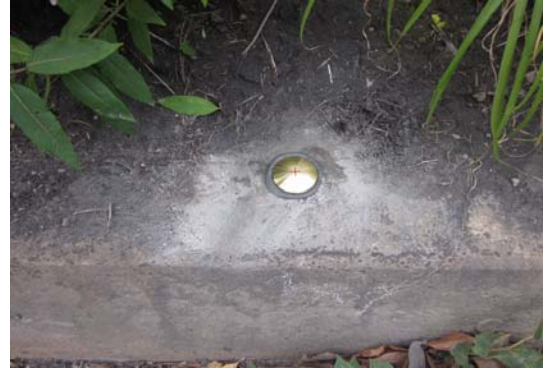
写真4 水準点設置完了
