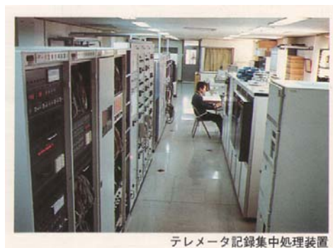
写真5 阿武山微小地震観測システム
