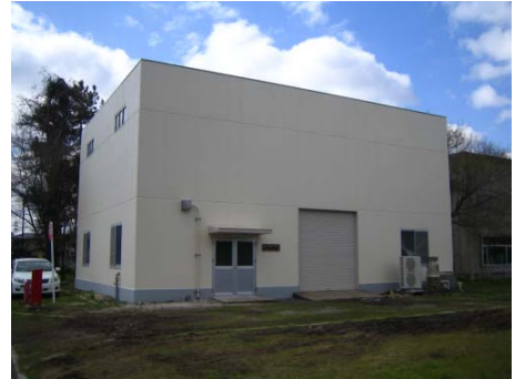
写真 1 新しくなった実験室建物
