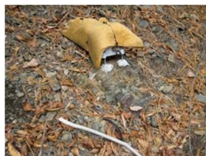
写真 4 ケーブル断線
