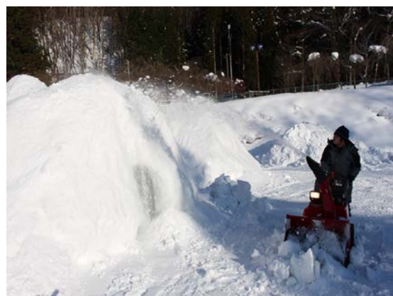
写真2. かまくらへの吹き付け作業
