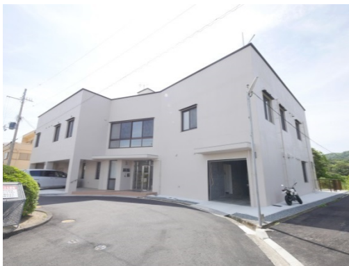
白浜海象観測所本館
