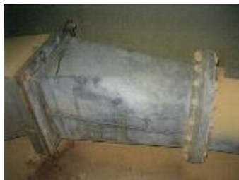
写真2 錆を落とした様子
