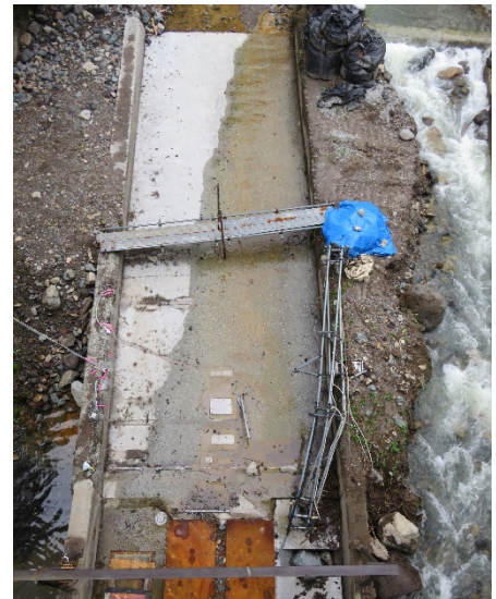
写真3. 復旧工事1回目完了後
