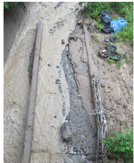
写真2. 足洗谷観測水路（被災後）
