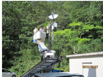
衛星通信機器の設置
