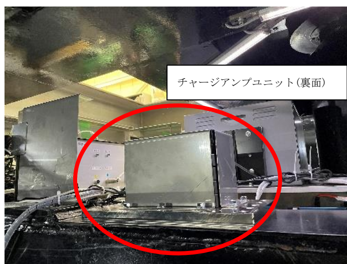
写真9 チャージアンプユニット固定の様子
