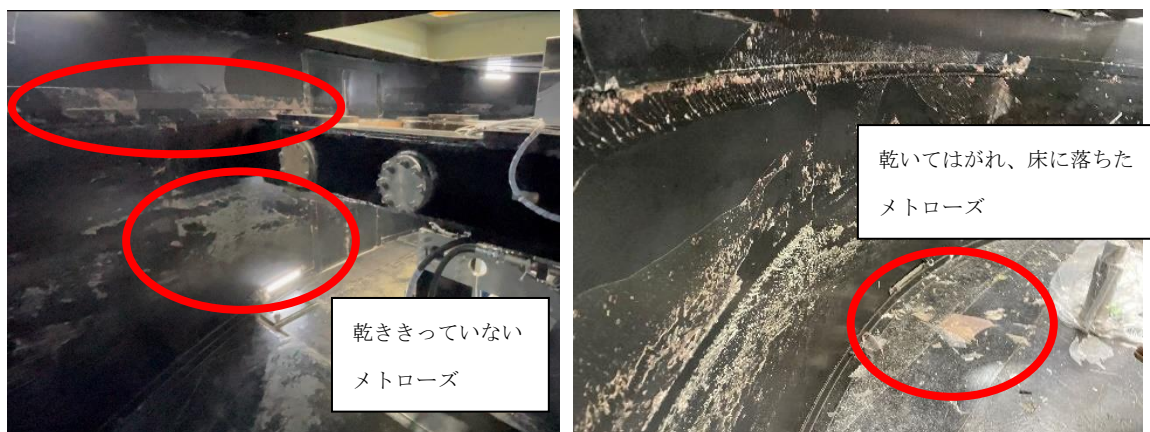
写真1 遠心载荷装置ピット内の様子 (右オーバーホール前、左オーバーホール中)
