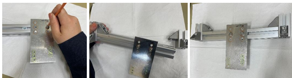
写真6：ジグ組立の様子
